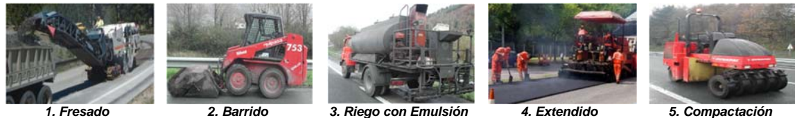
Figura 6. Puesta en Obra de la Mezcla Asfáltica
